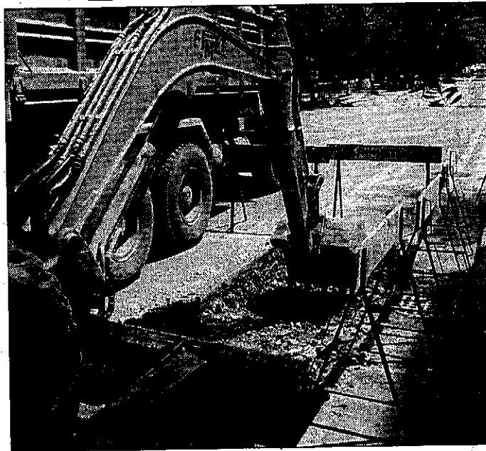
INTANTO SI SCAVA. I lavori in corso in città per la posa dei tubi del teleriscaldamento
